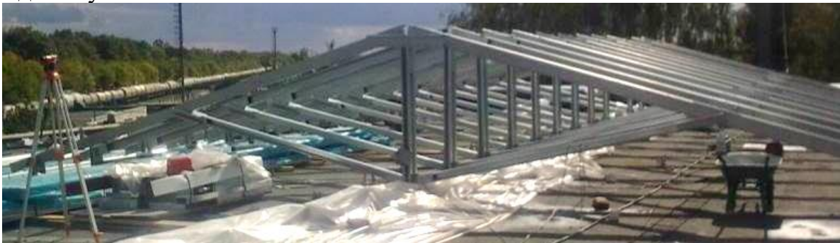
Рисунок 6 – Загальний вигляд кроквяної системи покриття, що випробовувалась
